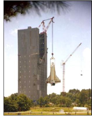
**La tour d'essais dynamiques de Huntsville, située au milieu d'autres bancs de l'époque Apollo, recevra le lanceur Ares 1 de 99m de haut. A gauche, le démontage en cours pour mise en configuration Ares. A droite, la mise en place d'un orbiter lors du développement de la Navette donne une idée de la taille. (doc. NASA)**
