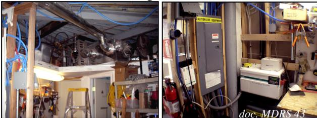
à gauche le système de chauffage dans un faux plafond du rez-de-chaussée et, à droite, le tableau de contrôle du système électrique (doc. MDRS 45)
