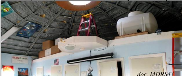
le réservoir d'eau et le système de pompage à partir de la réserve extérieure sont situés dans le loft au-dessus des chambres (doc. MDRS 43)
