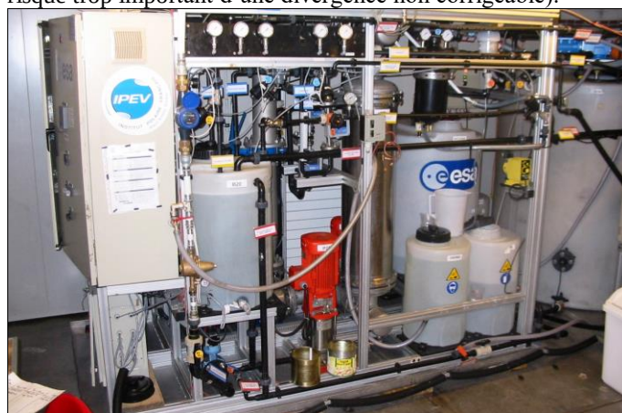
Le module de traitement des eaux usées, en Antarctique. (doc. ESA)
