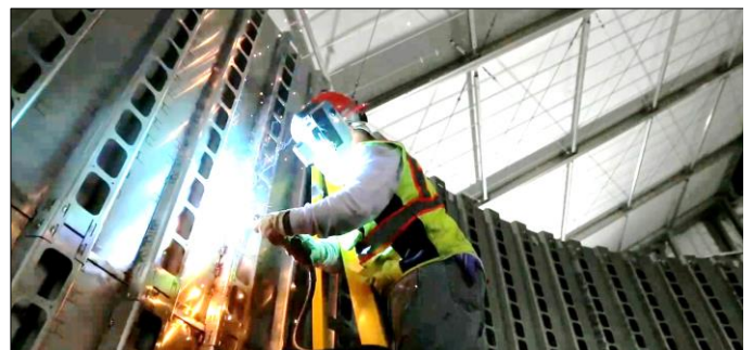
Soudage des longerons renforçant la tenue au flambage des viroles soumises aux charges axiales max ou non pressurisées. (SpaceX)
