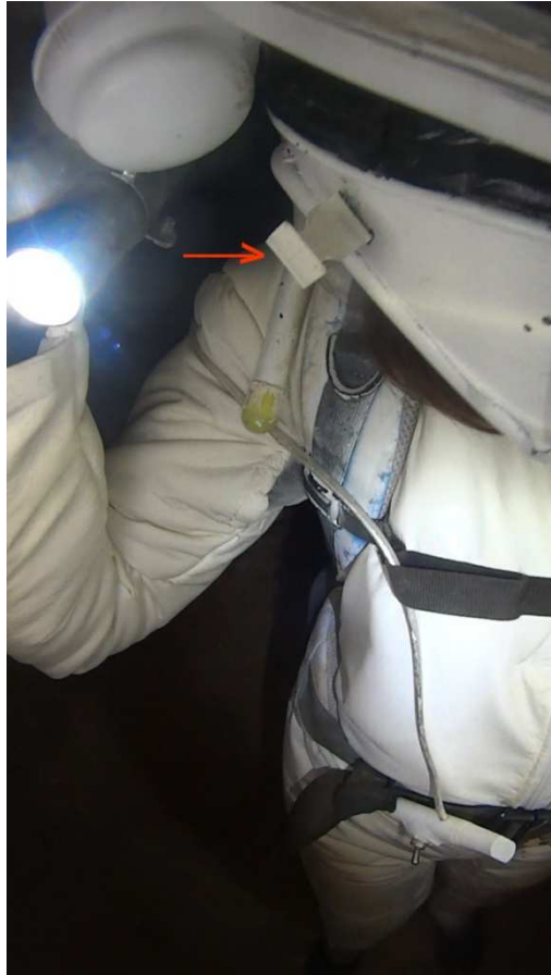
La flèche en haut à gauche indique la position de l'un des colliers de fixation en "U" de la collerette sur la tige qui apparaît en dessous ; ici la tige est donc « déclipée » du U.
