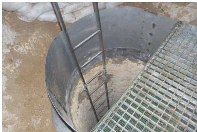
Le puits de la galerie du siphon (doc. J. P. Viard)
